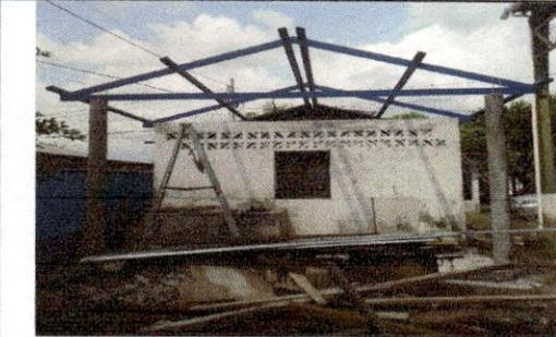
FOTO 4: SUSTITUCION DE SOPORTE DE MADERA POR METAL.
